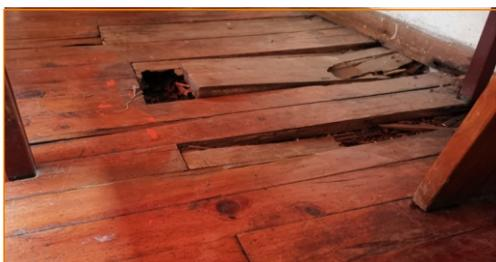
Bestandsaufnahme der von **Termiten geschädigten Holzböden** in den Klassenzimmern: 5 Räume brauchen dringend Beton mit Kunststoffauflage. Die Sanierung eines Raumes konnte für 2500 € aus Vereinsmitteln bewerkstelligt werden.
